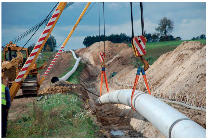
Budowa gazociągu przesyłowego w pagórkowatym terenie [10]
