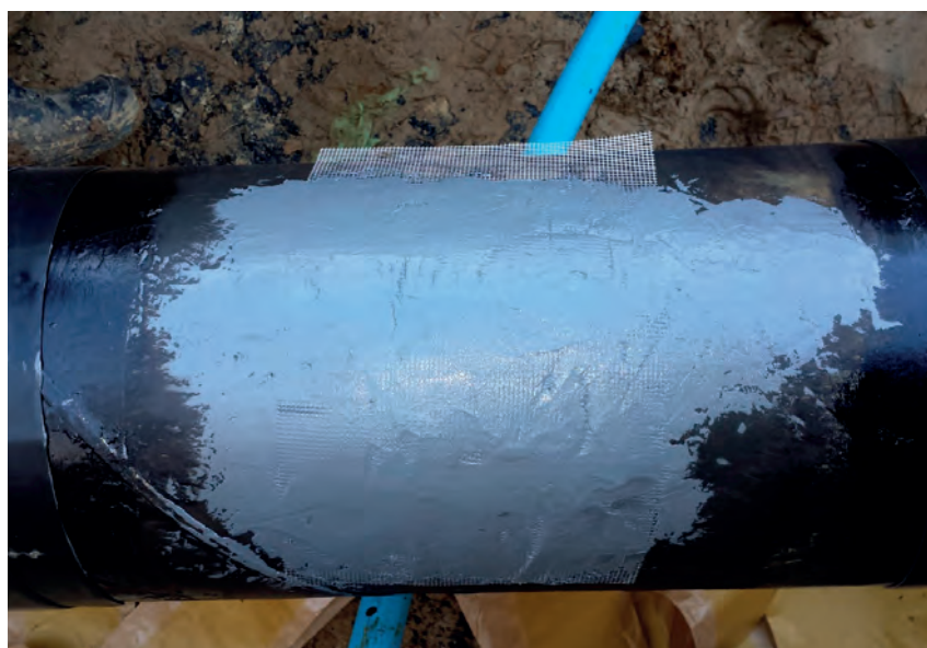
Naprawa wad powierzchniowych rurociągu, przy wykorzystaniu materiałów kompozytowych
