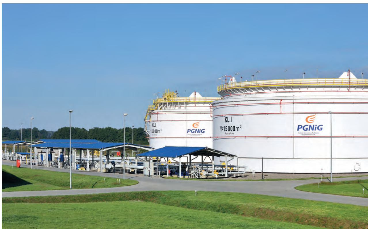
Główne elementy Terminalu Wierzbno to bocznica kolejowa, zbiorniki magazynowe ropy o pojemnościach 5 i 15 tys. m 3 , pompownia i podłączenie do rurociągu PERN. Fot. Paweł Chara
