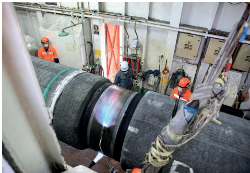
Budowa gazociągu Nord Stream – wyżarzanie odprężające spoiny obwodowej [10]
