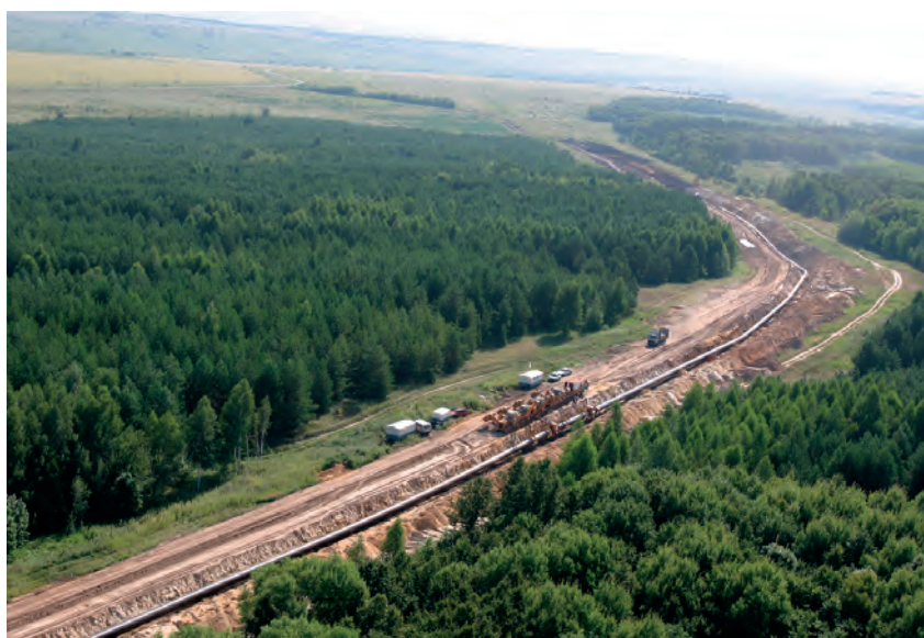
Budowa gazociągu przesyłowego
