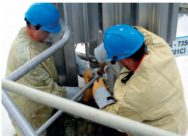
Pracownicy Odazotowni usuwali nieszczelność na parownicy odbudowy ciśnienia zbiornika magazynowego LNG. Fot. Maciej Rozwadowski
