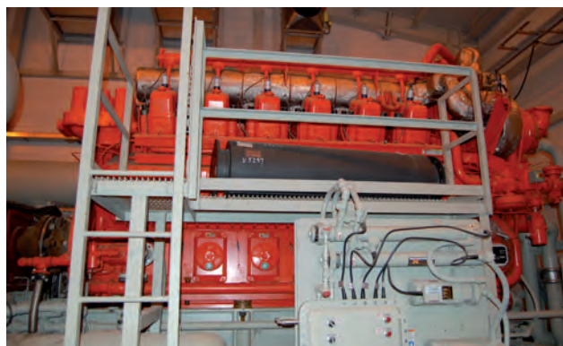
Taką potężną sprężarką będziemy zatłaczać gaz do złoża. Fot. arch. PGNiG Oddział w Sanoku
