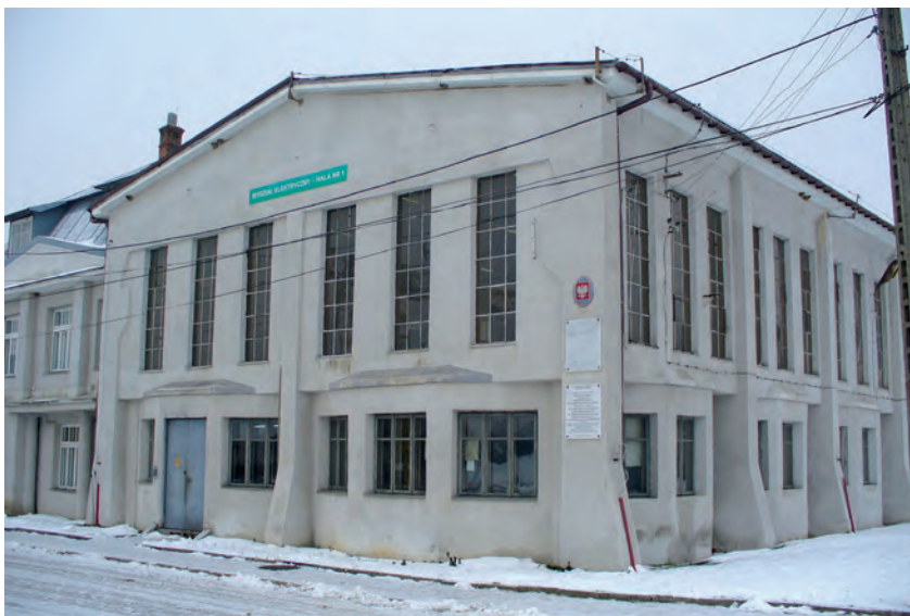
Budynek dawnej elektrowni. Fot. Jan Janocha
