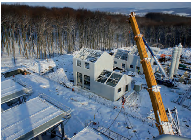
Na budowie. Fot. arch. PGNiG Oddział w Sanoku
