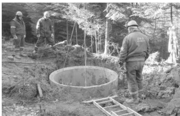
Przygotowanie kopanki do prac likwidacyjnych. (fot. ze zbiorów autora)
