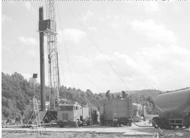
Rurowanie i cementowanie odwiertu „TW 1”. (fot. archiwum Exalo Drilling SA)
