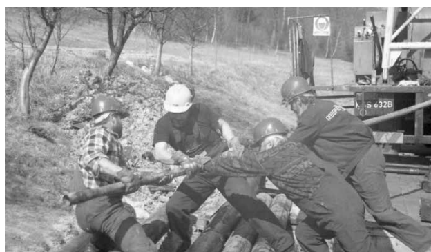
Rozkręcanie rur okładzinowych mechanicznie i ręcznie.
