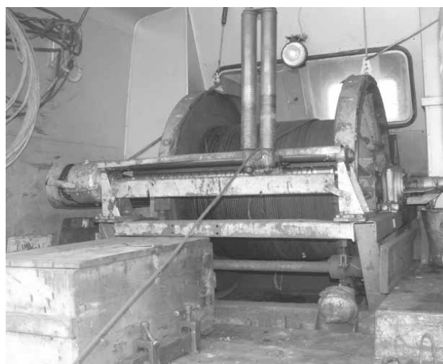
Wyciąg geofizyczny. (fot. ze zbiorów autora).
