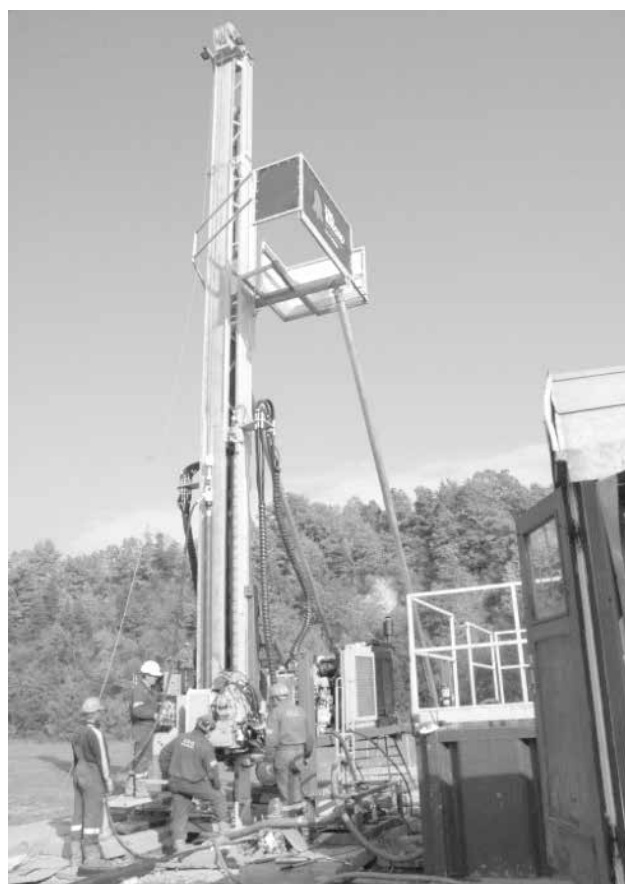
Szkolenie na wiertnicy „Atlas Copco” (fot. B. Bajorski)
