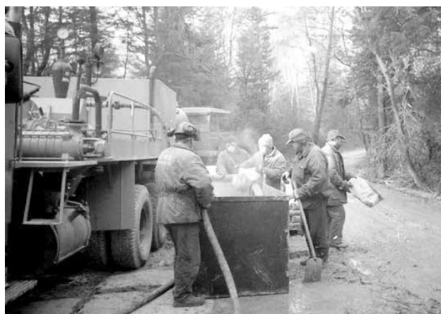
Sporządzanie roztworu cementowego na leju cementarki i ręcznie strumieniem wody. (fot. ze zbiorów autora).
