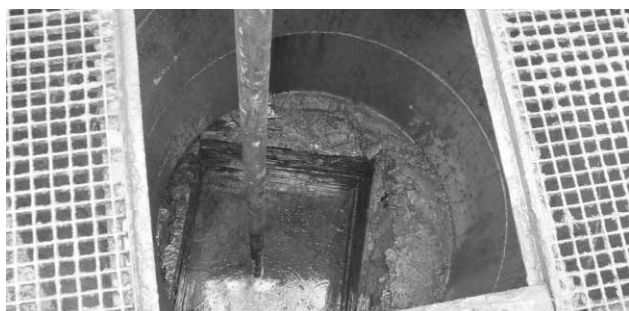
Czyszczenie pogłębianej kopanki (fot. ze zbiorów autora).
