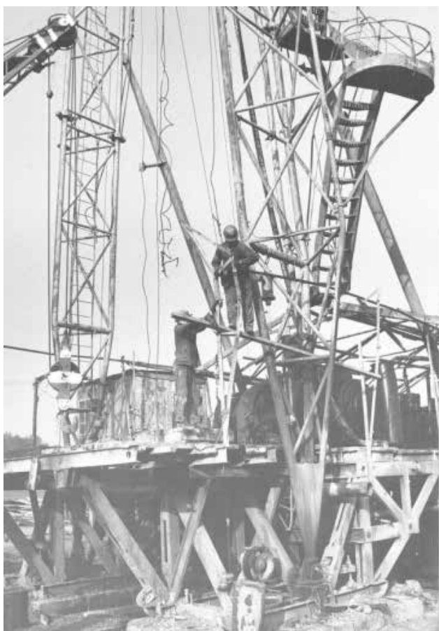
Kopalnia Smolarzyna-9, urządzenie wiertnicze BU-75, Kierownik kopalni Gutterch Czesław. Głębokość otworu 2256m. Czas wiercenia: 19.IV.1984r.-2.VII.1984r. Foto Stanisław Pater X.1984r. Demontaż urządzenia. (fot. archiwum autora)
