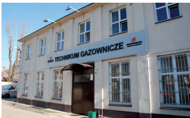
Budynek warsztatów szkolnych przy ul. Targowej w Łodzi. Fot. arch. MSG
