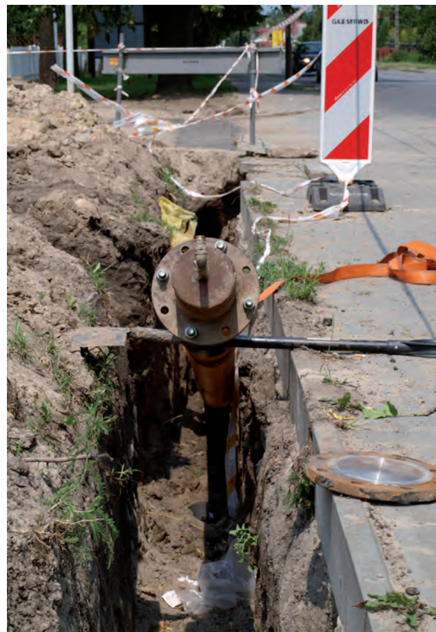
Modernizacja gazociągu w Sycowie. Fot. Leszek Łuczak
