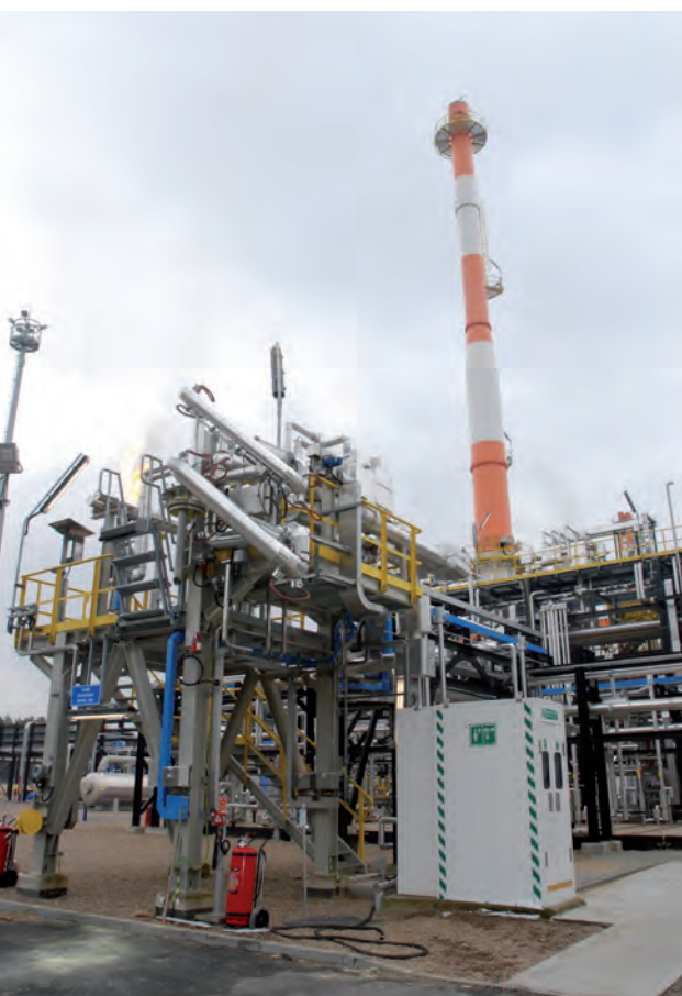
Najwyższym elementem instalacji Ośrodka Centralnego Lubiatów jest komin instalacji odzysku siarki o wysokości 60 m. Fot. Magdalena Wajda
