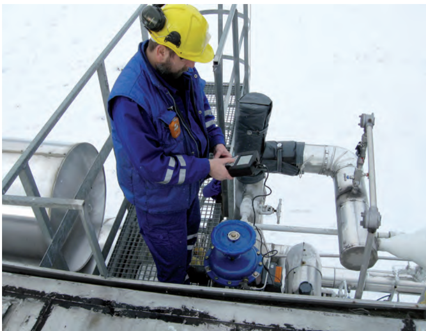
Automatyk KRNIGZ Dębno Kazimierz Kozłowski w trakcie konfiguracji ustawnika zaworu Z1A-C1. Fot. arch. PGNiG SA Oddział w Zielonej Górze
