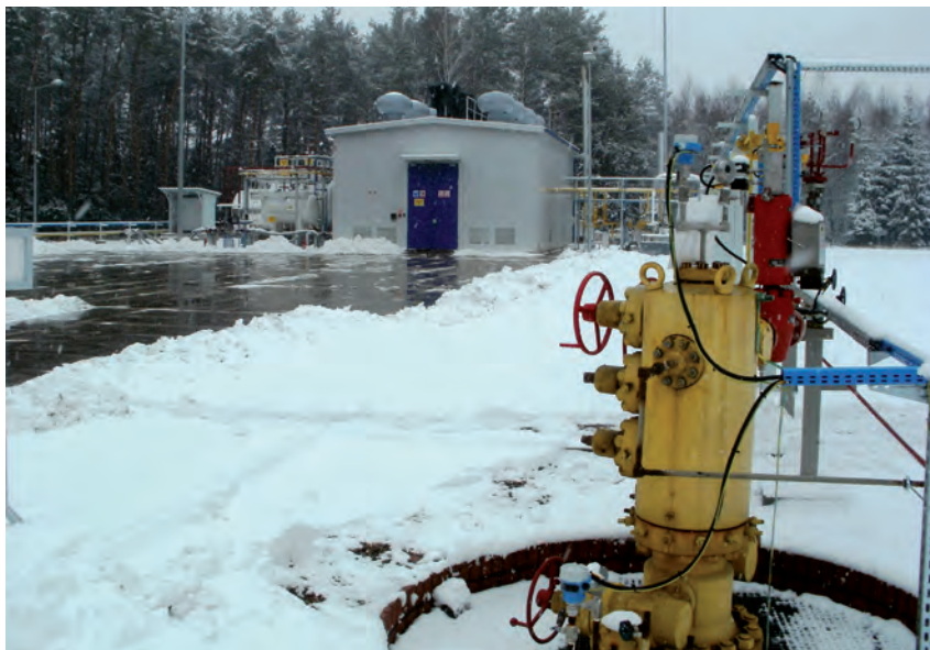
Na terenie OP Winna Góra zlokalizowano kontener technologiczny, po jego prawej stronie – układ podgrzewacza liniowego, po lewej – zbiorniki inhibitora korozji, metanolu i wody złożowej, na pierwszym planie głowica odwiertu Winna Góra-1. Fot. Bogumiła Orlicka
