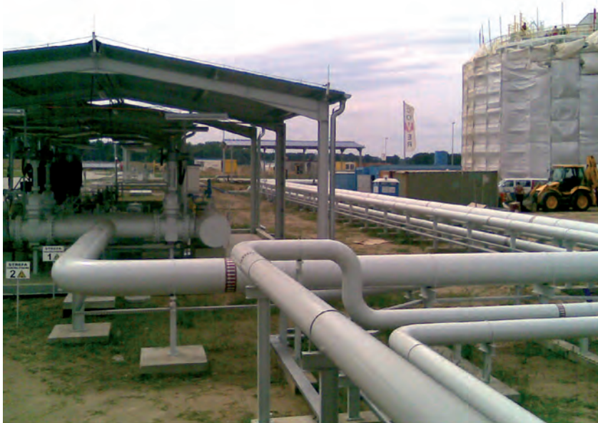
Nowoczesne metody spawania zastosowano w Wierzbnie. Fot. arch. PGNiG Technologie Sp. z o.o.
