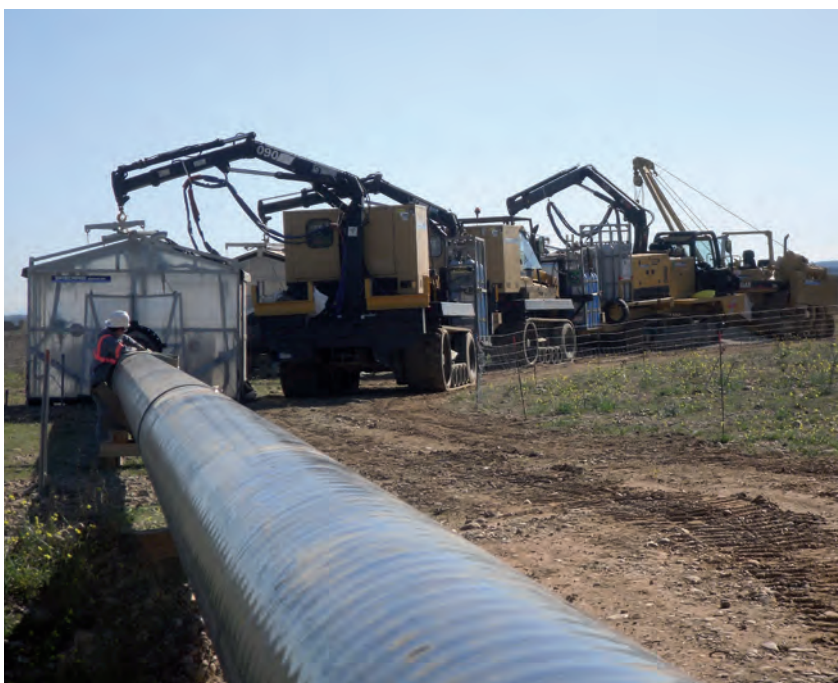
We Francji spawaliśmy ponad 20 kilometrów gazociągu. Fot. arch. PGNiG Technologie Sp. z o.o.
