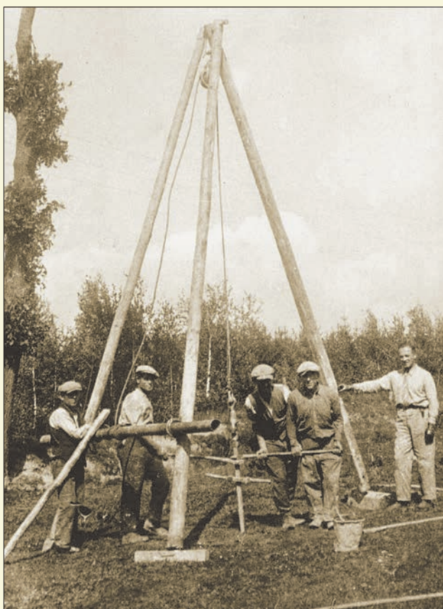
Ręczne wiercenie otworu strzałowego /scan. „Dawno temu w Karpatach”/
