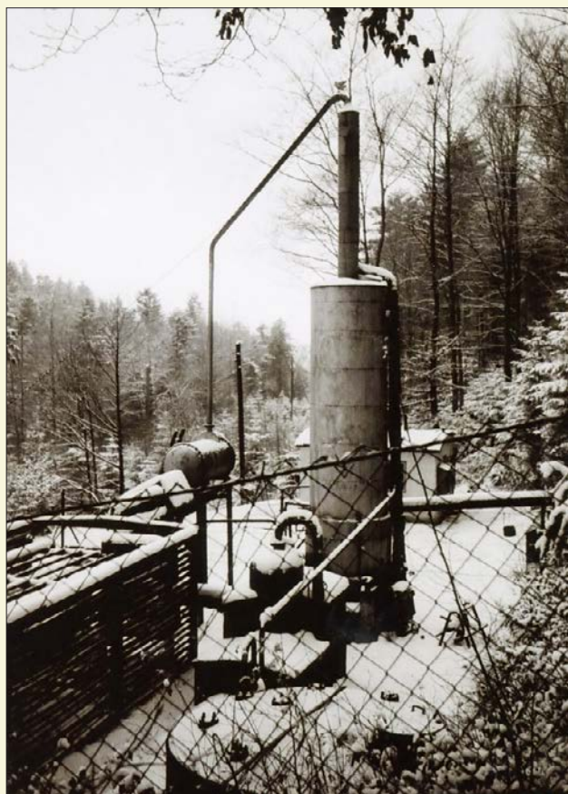
Stabilizacja ropy w Klimkówce /arch. MPNiG w Bóbrce/
