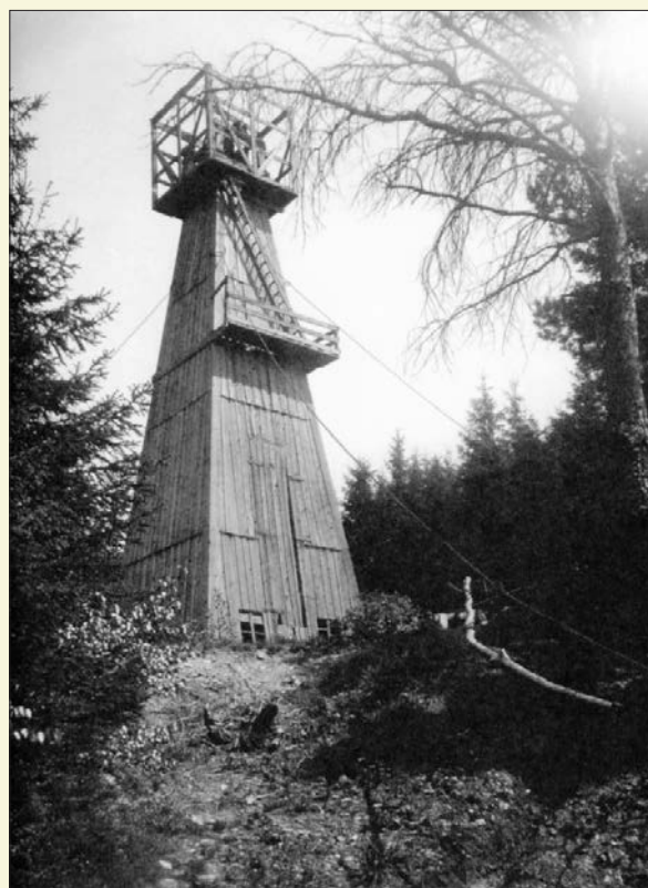
Wiertnie udarowe na kopalni Klimkówka, z prawej wiercenie otworu „Ela-2” /fot. arch. MPNiG w Bóbrce/
