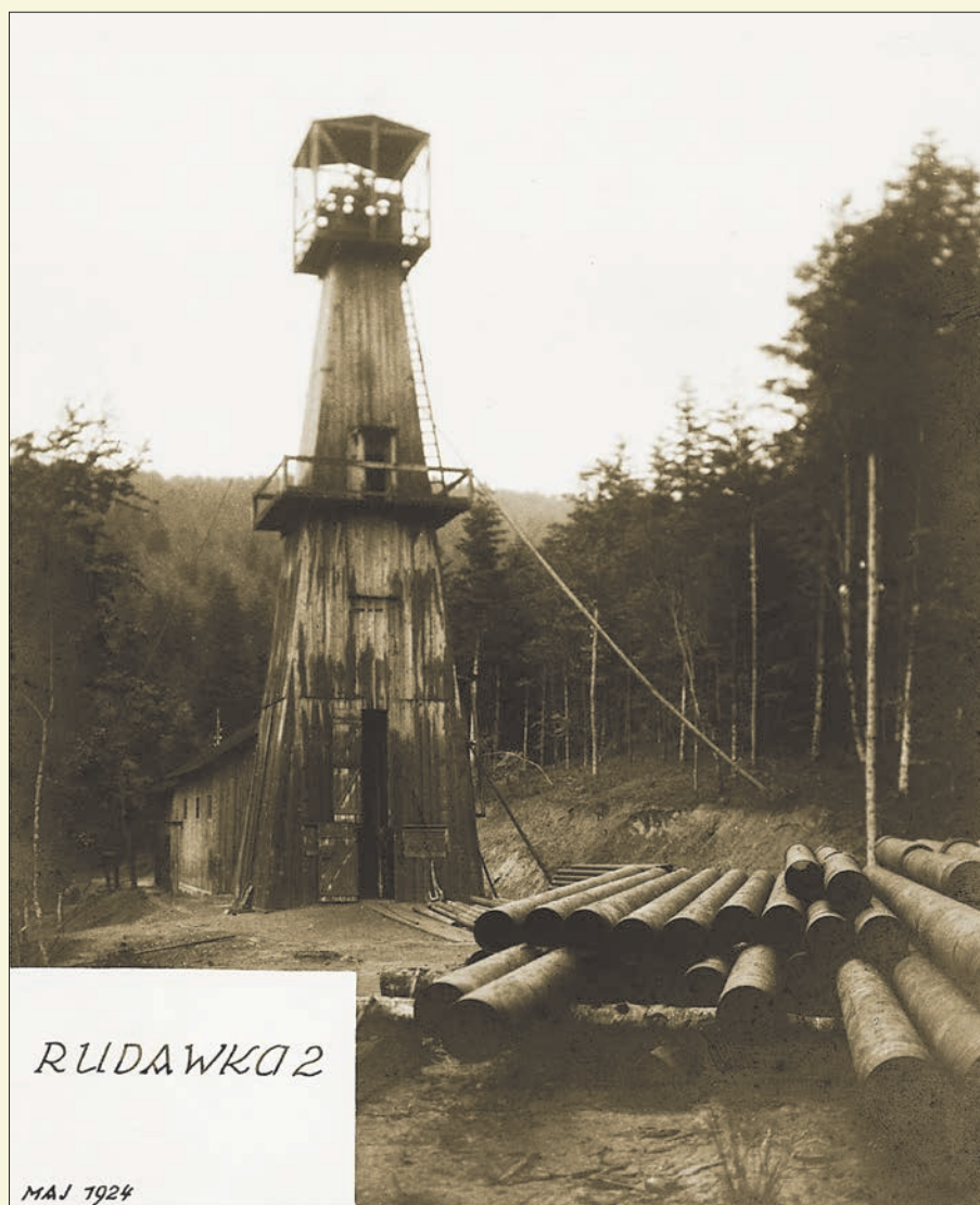
Wiercenie otworu „Rudawka-2” /fot. arch. MPNiG w Bóbrce/
