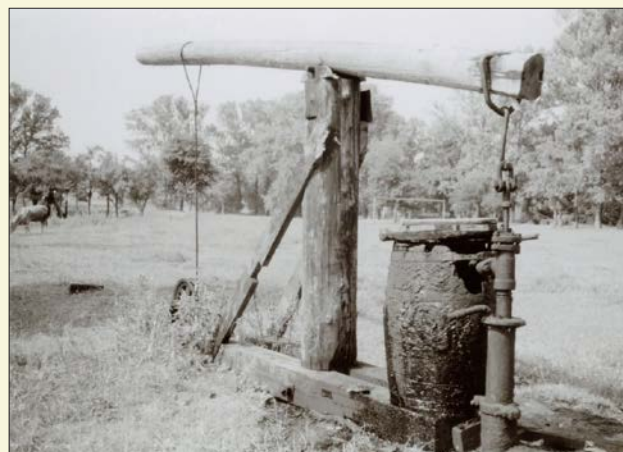
Jeden z pierwszych otworów usytuowany za dworem „Ostoja” przy drodze Krosno-Rymanów. Obecnie w tym miejscu wybudowano obiekt sportowy /scan arch. MPNiG w Bóbrce/
