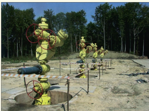
Głowice otworów PMGZ Strachocina (skan „PMGZ Strachocina” RUTHENUS – Krosno 2011)
