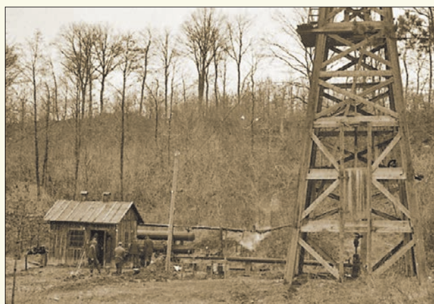
Kopalnia Strachocina – prace przy stacji redukcyjno-pomiarowej (fot. archiwum Fundacji Bóbrka)
