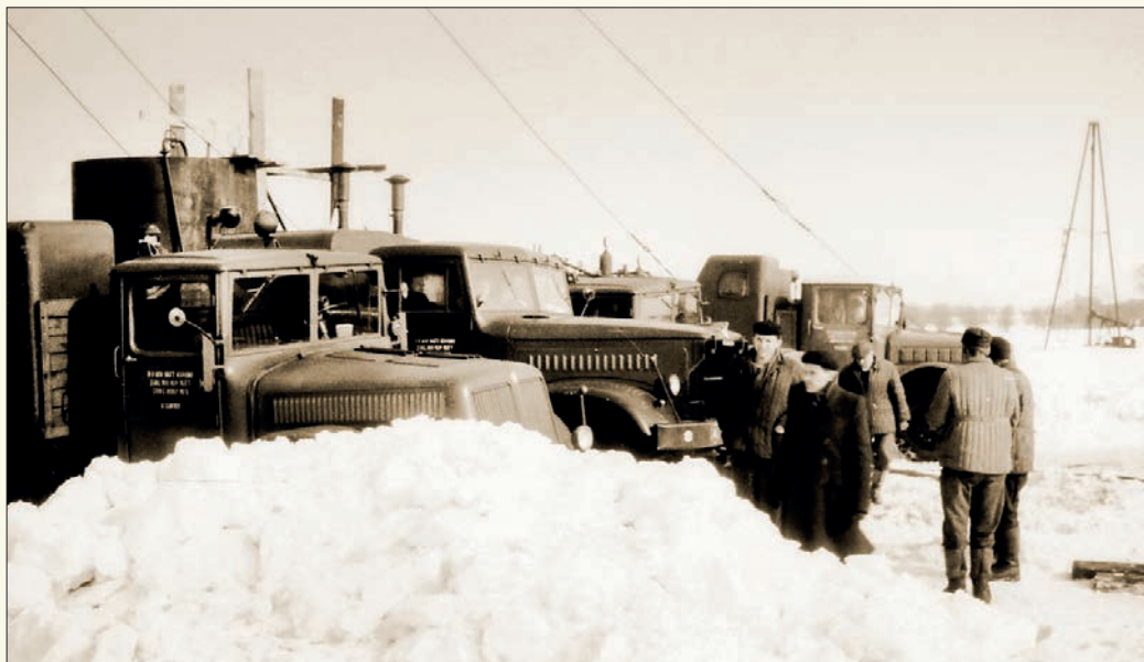
Zespół agregatów przygotowany do zabiegu szczelinowania na kopalni Węglówka II (fot. archiwum Fundacji Bóbrka)
