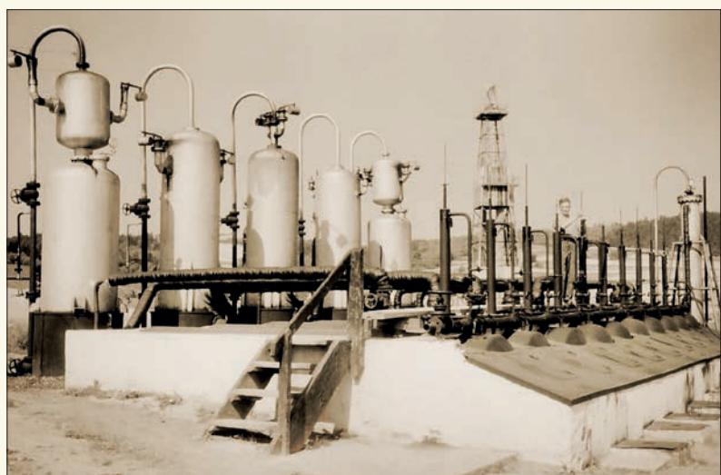
Kopalnia Węglówka II – bateria ropy nr 2 (fot. archiwum Fundacji Bóbrka)
