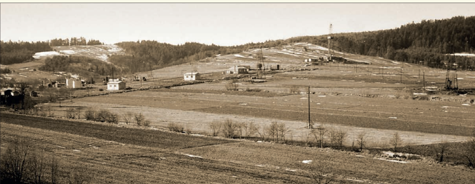
Panorama budowanej kopalni Węglówka II (fot. Zbigniew Jabczyński)
