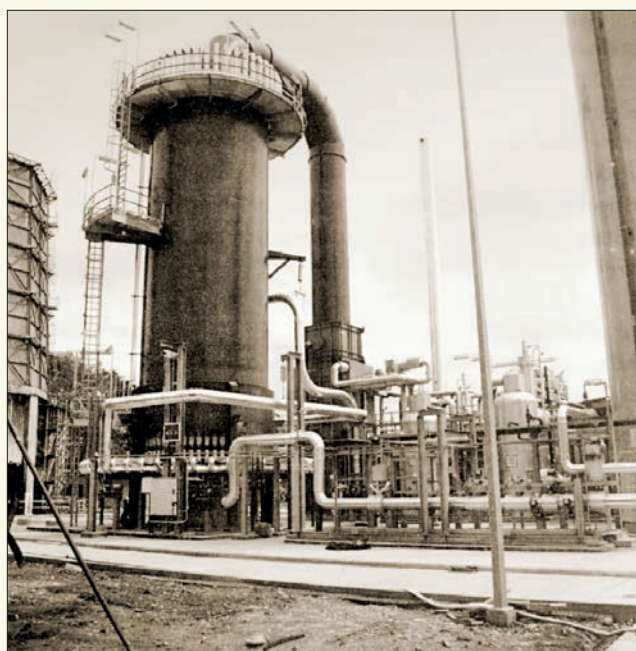
Reformer wytwórni wodoru o zdolności produkcyjnej 8 000 nm 3 /h (skan „Chemik” nr 10/2012, t. 66)
