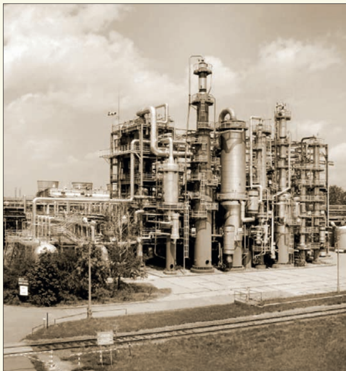
Instalacja utleniania cykloheksanu wybudowana w latach 70. XX wieku (skan „Chemik” nr 1/2012, t. 66)
