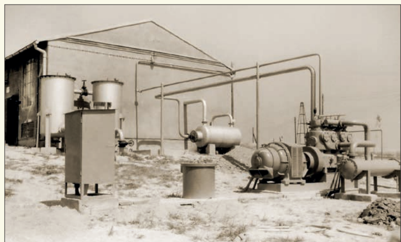
Instalacja i tłocznia gazu, później budynek OCZ kopalni Węglówka II (fot. archiwum Fundacji Bóbrka)
