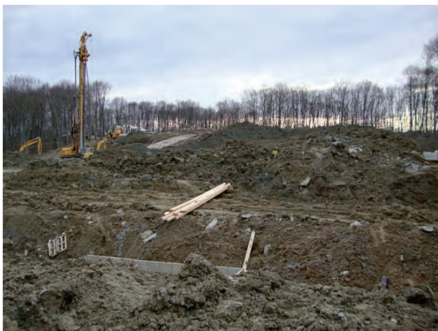
Roboty ziemne oraz palowanie pod teren Ośrodka Centralnego
