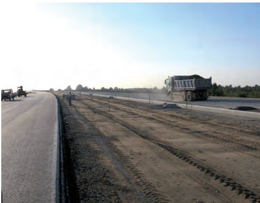
Budowa autostrady A4 na odcinku „Węzeł Rzeszów”. Fot. arch. PN Diament
