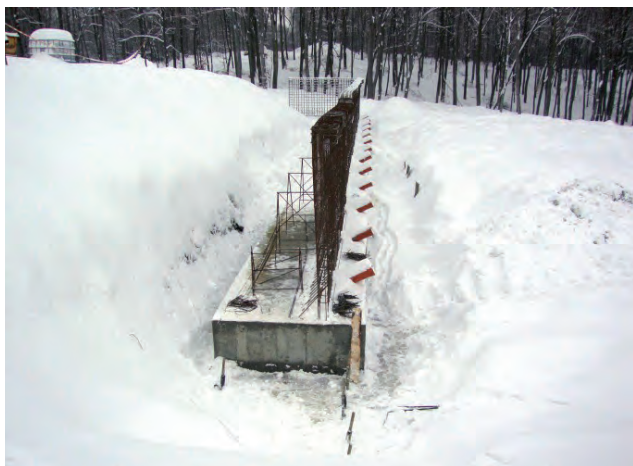
Budowa murów oporowych Ośrodka Centralnego – zima 2009/2010
