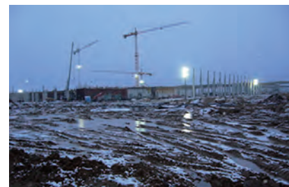
Fot. 3 Budowa fabryki Bridgestone – grunt tuż przed wykonaniem modyfikacji podłoża gruntowego Fot. P. Kuśmierek
