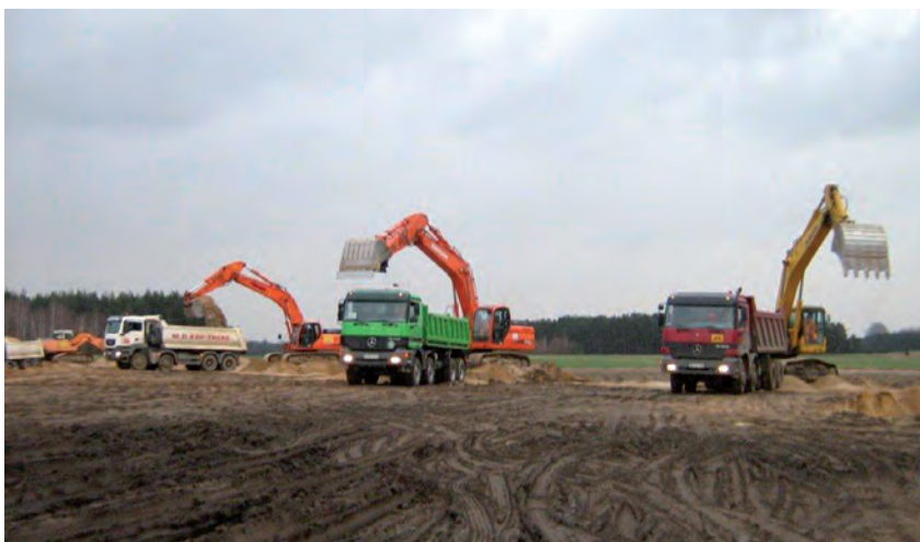
Prace rekultywacyjne składowiska odpadów innych niż niebezpieczne i obojętne w miejscowości Orchów gm. Łask. Fot. arch. PN Diament
