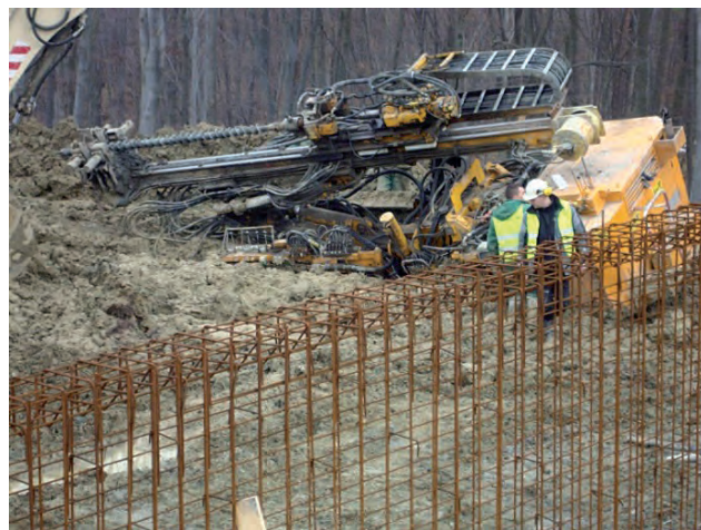
Roboty związane z wykonaniem palowania – w tak trudnym terenie nawet sprzęt specjalistyczny miał problemy...
