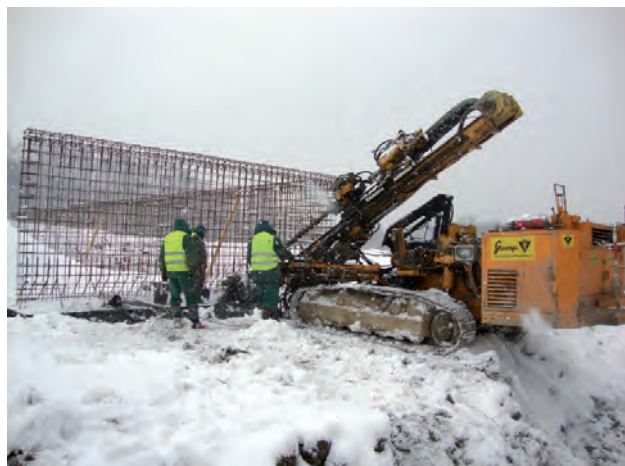
Budowa murów oporowych Ośrodka Centralnego – zima 2009/2010
