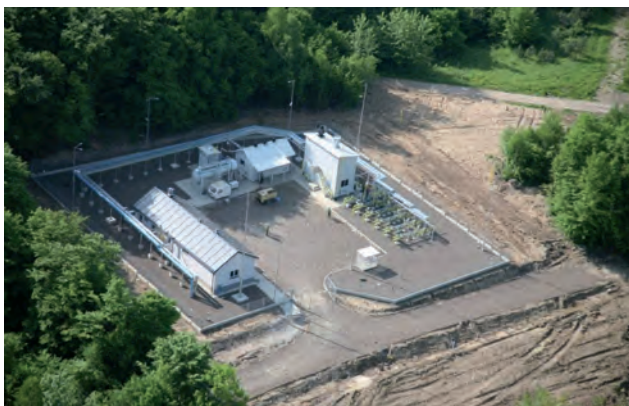
Ośrodek Grupowy nr 1 – widok z lotu ptaka
