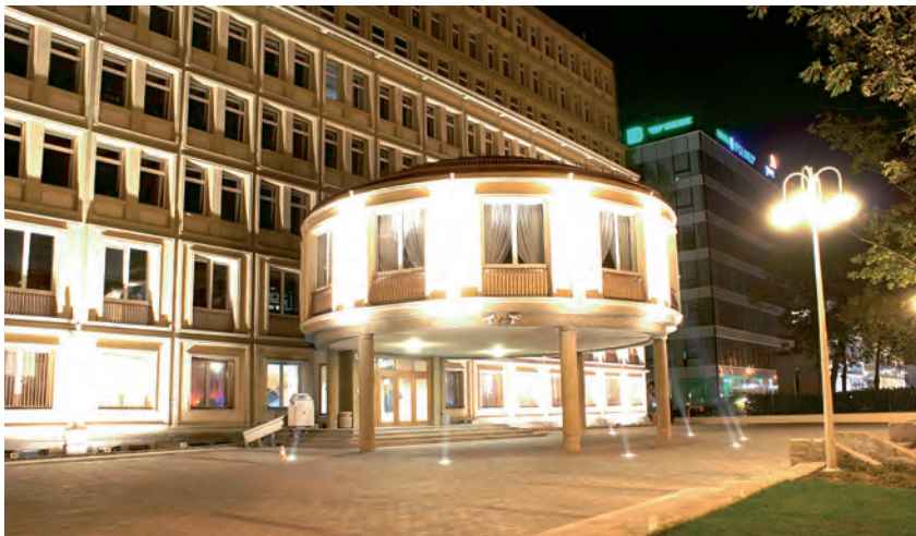
Siedziba firmy. Fot. arch. PNiG Kraków Sp. z o.o.
