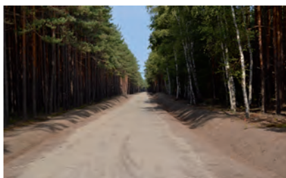
Fot. 5-7. Wykonanie drogi dojazdowej do wiertni Maszewo. Fot. P. Kuśmierek
