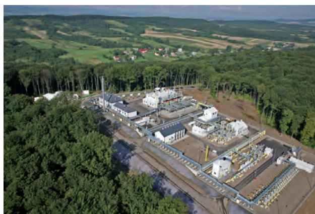
Ośrodek Centralny – budynki oraz urządzenia technologiczne
