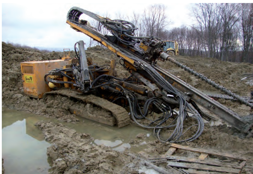
Roboty związane z wykonaniem palowania
