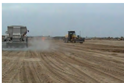
Fot. 1 Sprzęt służący do dozowania spoiwa hydraulicznego. Fot. P. Kuśmierek
