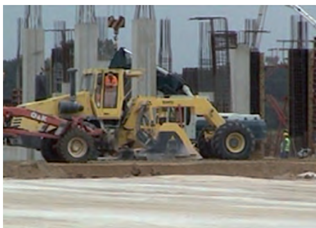
Fot. 2 Maszyna służąca do homogenizowania spoiwa z gruntem „Recykler”. Fot. P. Kuśmierek
