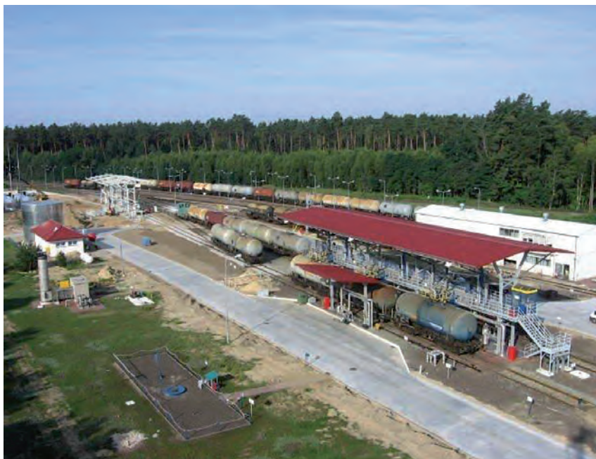
Rozbudowa Ekspedytu Naftowego „Barnówko” w miejscowości Barnówko. Fot. arch. PN Diament
