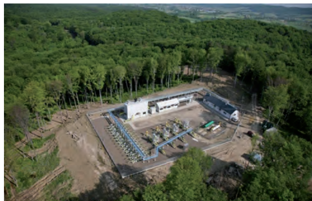
Ośrodek Grupowy nr 2 – widok z lotu ptaka
