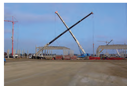
Fot. 4 Budowa fabryki Bridgestone – efekt finalny Fot. P. Kuśmierek
