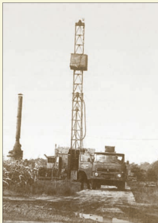
Kopalnia Żołynia-31, urządzenie wiertnicze OP-1200, Kierownik kopalni Czajka Jan. Głębokość otworu 505 m. Czas wiercenia: 17.09.1969-04.10.1969 r. Foto T. Pabis (fot. ze zbiorów autora)
