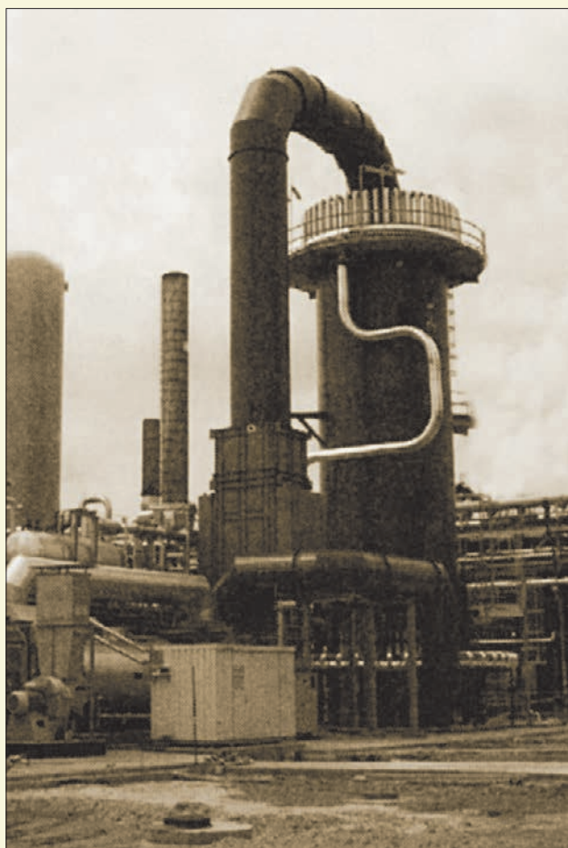
Wytwórnia wodoru poprzez rozkład metanu w PFZA-Tarnów (scan. „Chemik” nr 10.2012 tom 66)
