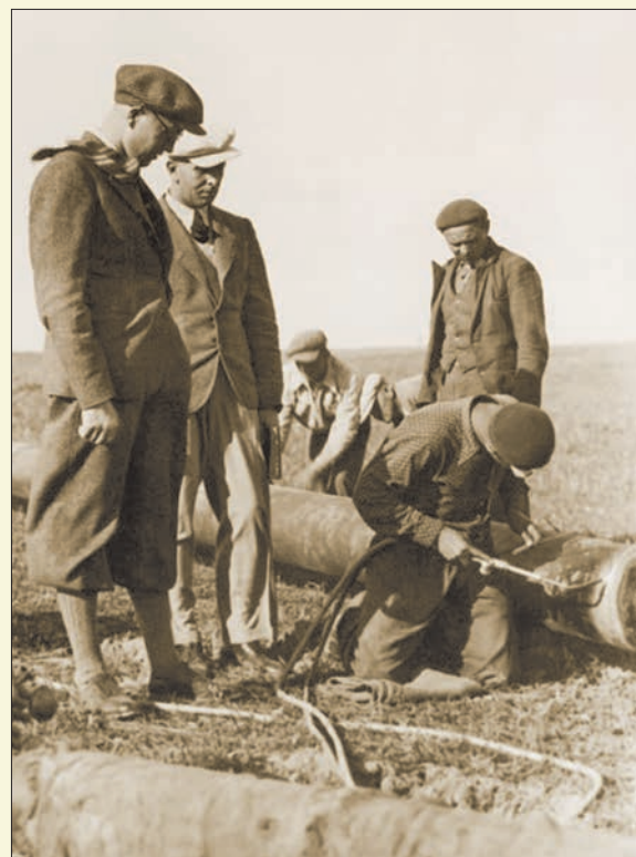
Spawanie Gazociągu Centralnego 1937-1938 (fot. arch. Kazimierz Nycz)
