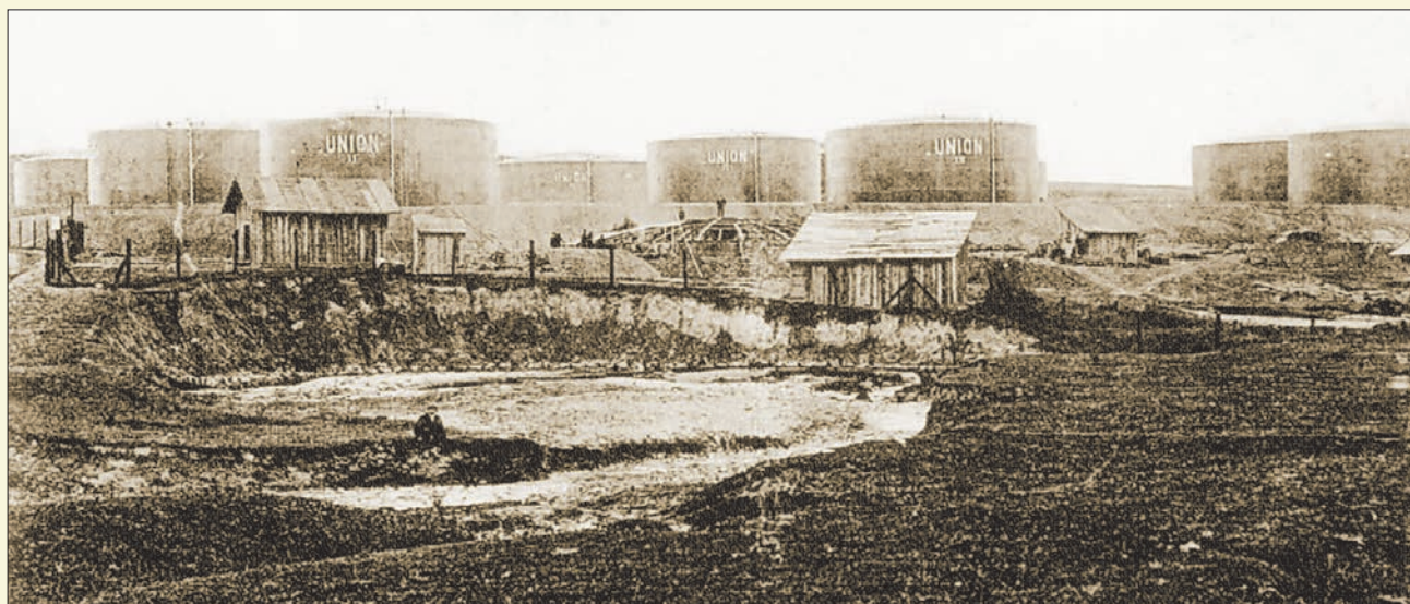
Borysław zbiorniki ropy naftowej (fot.arch.MPNiG w Bóbrce)
