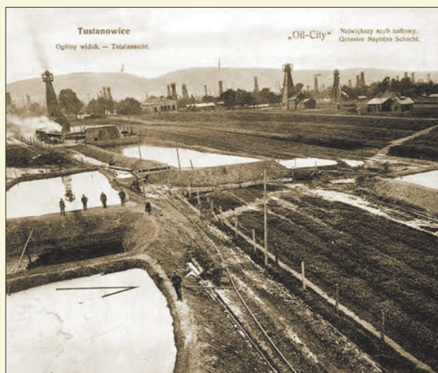
Tustanowice – ziemne zbiorniki ropy (fot. arch. MPNiG w Bóbrce)
