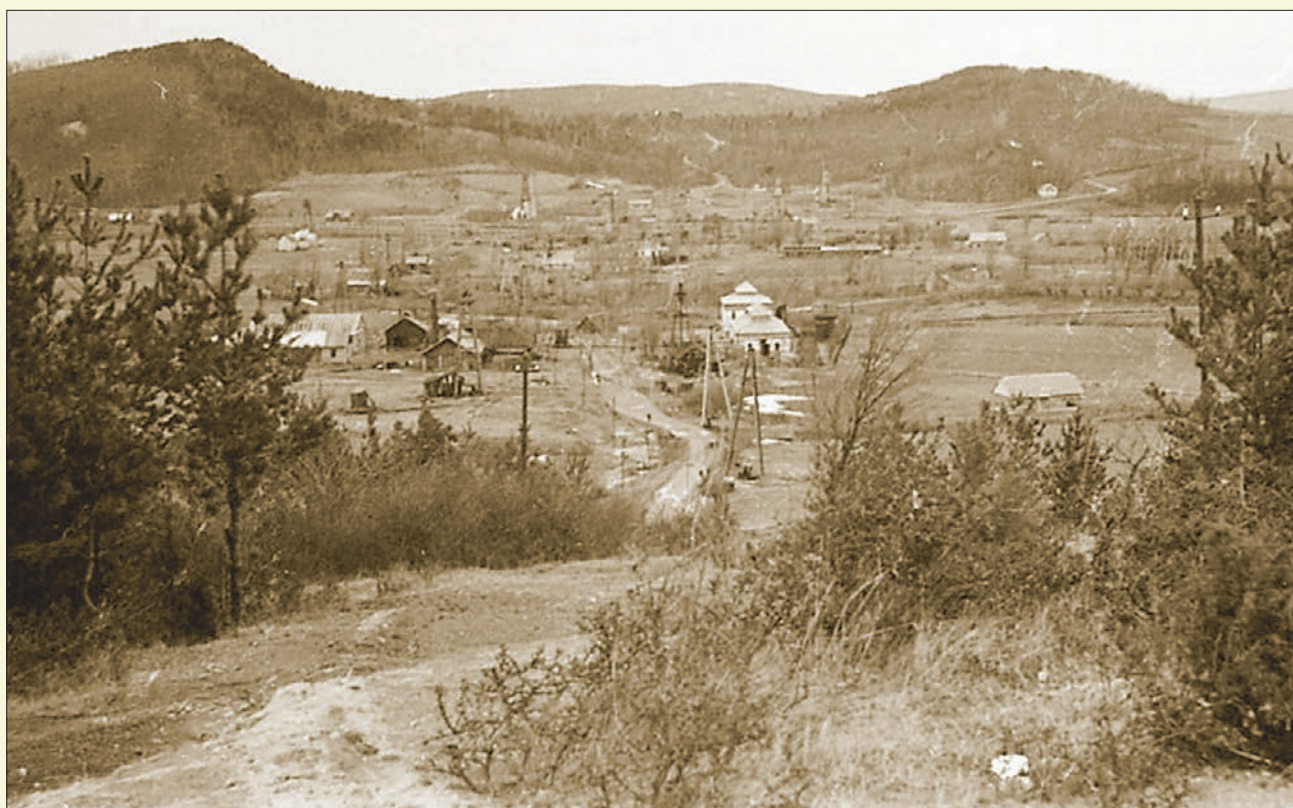
Widok z kopalni Rogi na kopalnię Równe po prawej budynki gazoliniarni (arch. MPNiG w Bóbrce)
