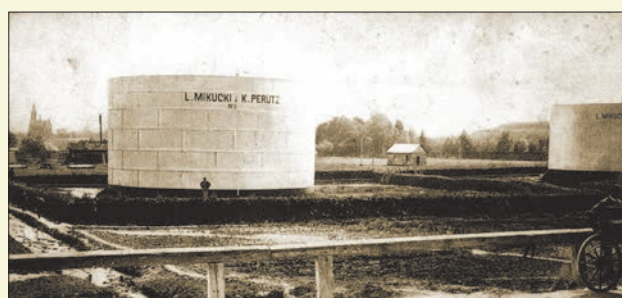
Zbiorniki ropy firmy „L. Mikucki & K. Perutz” (fot. arch. MPNiG w Bóbrce)
