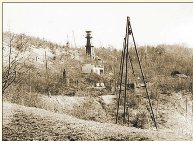
Kopalnia Rogi, nad budynkiem kieratu widoczna wieża otworu „Emilia-4” (arch. MPNiG w Bóbrce)
