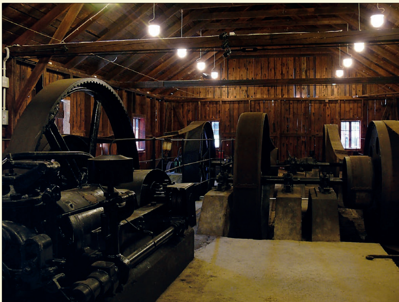
Aranżacja wnętrza kieratu (fot. arch. Fundacja Bóbrka)
