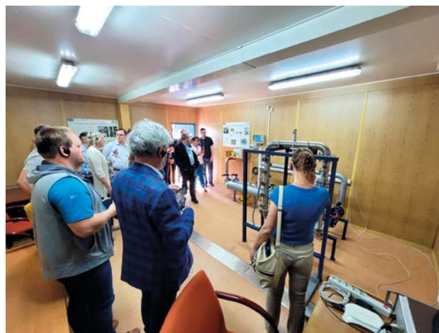
Wizyty techniczne – stacja monitorowania korozji przy otworze geotermalnym Mszczonów IG-1. Fot. A. Kasztelewicz
