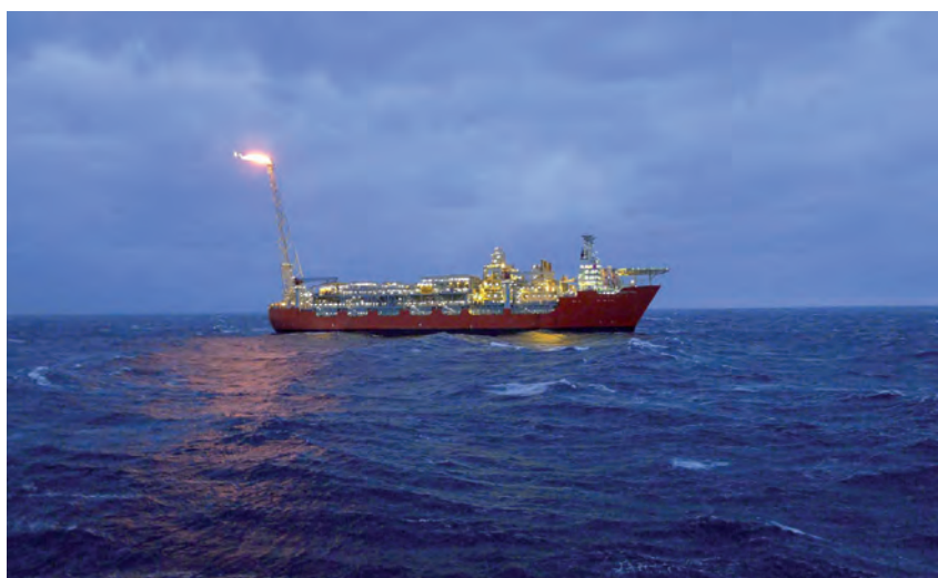
Fig. 6. Zdjęcie Platformy pływającej SKARV FPSO podczas pracy na złożu. Źródło: BP Norge
