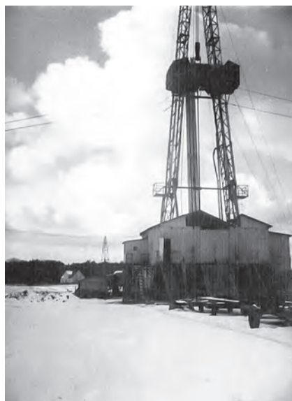
Wiercenia w rejonie Przemyśl, lata 70. XX w. Fot. arch. PGNiG SA
