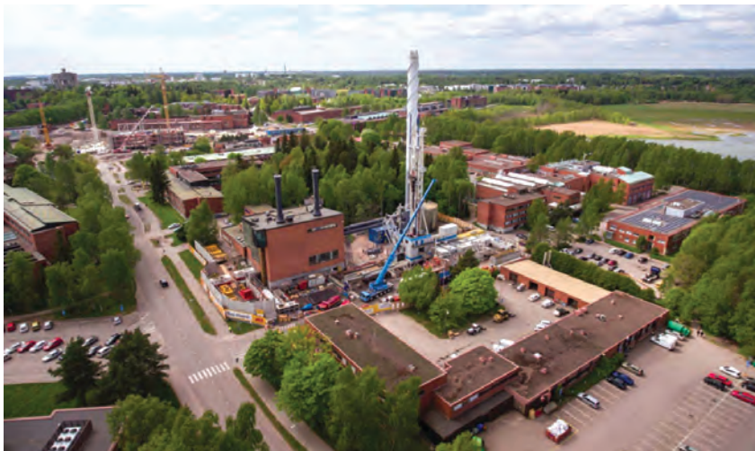
Rys. 2. Wiertnica podczas wiercenia otworu geotermalnego w mieście Espoo, Finlandia (źródło: St1 Deep Heat Ltd.)
