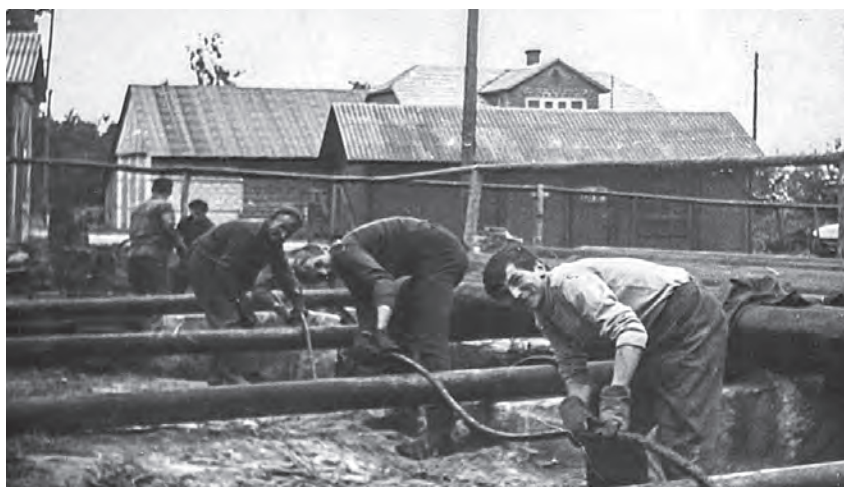
Budowa pierwszych gazociągów – Kopalnia Przemysł-Zachód. Fot. arch. PGNiG SA
